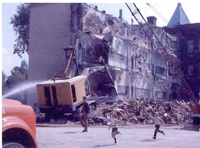
Figure 5.36 Démolition de l'ancien collège Saint-Henri (Source : SHSH.)
