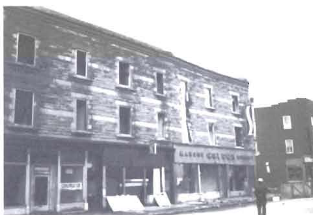
Figure 5.14 Démolition des bâtiments du secteur exproprié sur le côté sud de la rue Saint-Jacques à l'angle de la rue Saint-Ferdinand On note la présence de commerces au rez-de-chaussée. (Source : Archives de la STM.)
