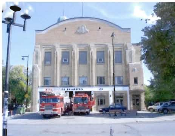
Figure 4.14 Poste d'incendie n° 23 (Source : Catherine Séguin, 2006.)
