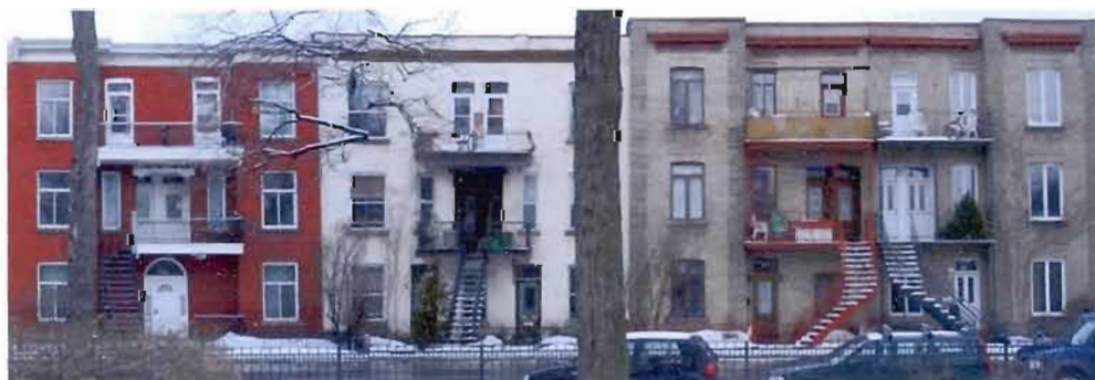
Figure 4.19 Typologie des habitations construites à partir de 1904 dans le secteur du square De gauche à droite : un triplex à cinq logements (3925-3933, rue Saint-Antoine), un triplex à six logements (3913-3923, rue Saint-Antoine) et deux triplex à trois logements (3707-3911 et 3901-3905, rue Saint-Antoine).
