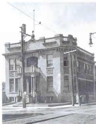
Figure 4.8 Le presbytère de l'église Saint-Thomas d'Aquin, 1911 (Source : « Presbytère St-Thomas-d'Aquin », 1911 ; BANQ, 5-55-d.)
