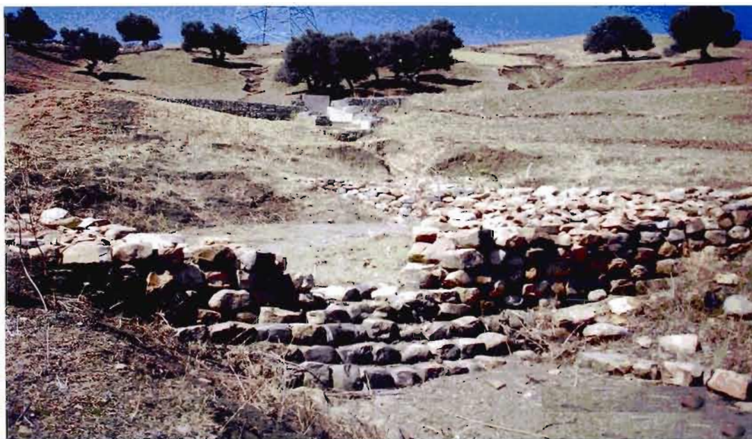
Figure 2.16 Seuil en pierres sèches implanté sur un ravin dans le bassin versant de l'oued Barbara. (Photo : SOUADI Youssef, 2009)
